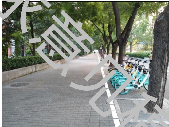
图 3-23 用白色方砖设置的自行车停车引导线
