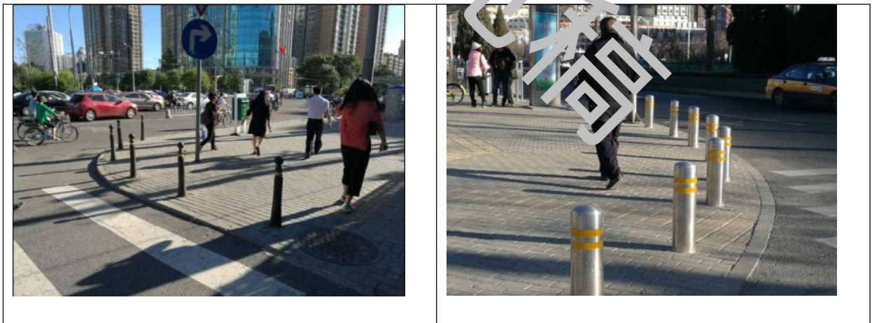
图4-3 适宜的阻车桩样式和高度
