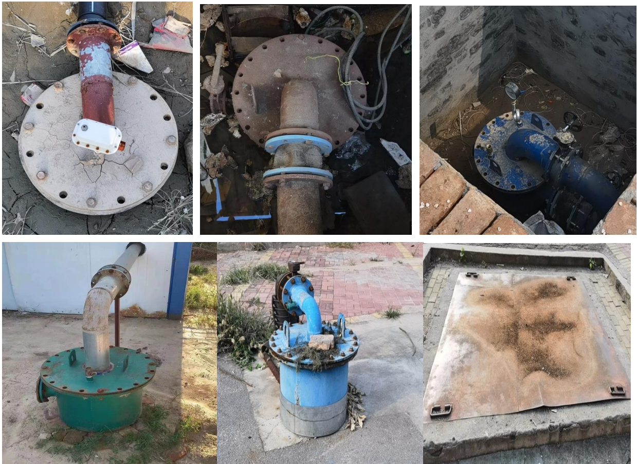
照片 3-1 矿区井口照片
