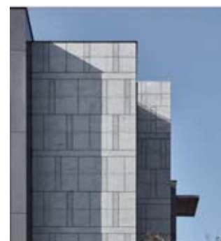
山墙面采用错缝，深浅跳色处理
