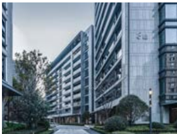
建筑墙面耐久整洁
