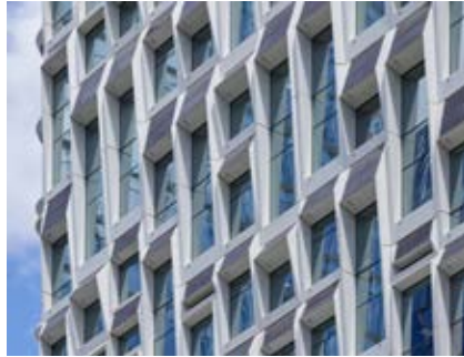
结合斜面造型，隐藏式太阳能板
