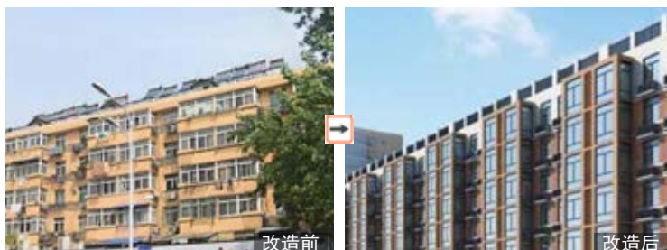
屋顶增设格栅围墙遮挡设备
