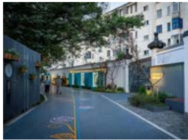
修缮场地路面
