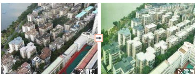
拆除违章加盖，原有破损坡屋面更换树脂瓦，地面采用地坪漆重新喷涂
