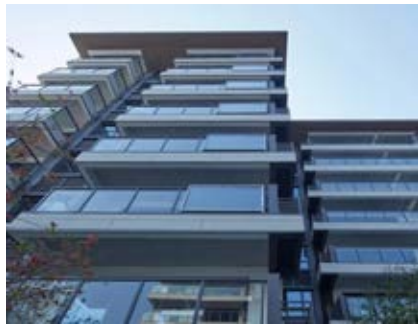
太阳能板颜色同玻璃相结合
