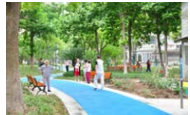
彩色沥青道路，美化路面铺装
