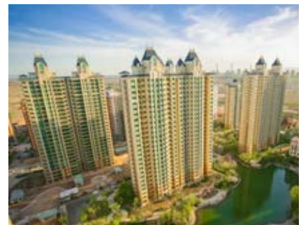
脱离建筑主体的“穿衣带帽”
