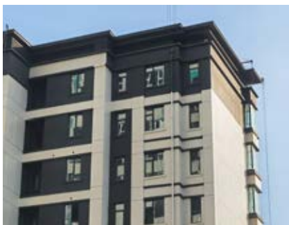
落水管打断立面线脚
