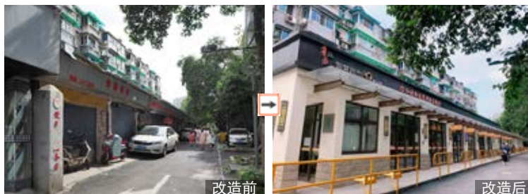
保留原有建筑墙体，将原有废弃车棚翻新改造为社区党群活动中心
