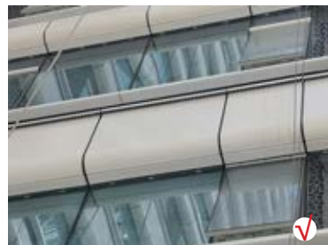
楼体亮化设施隐蔽处理
