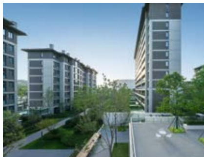
结合开窗营造虚实有序的山墙面
