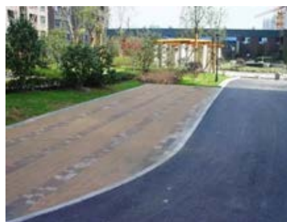
消防扑救面无美化处理
