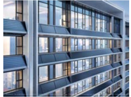
结合斜面造型，隐藏式太阳能板
