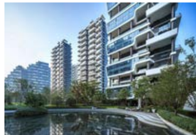
建筑风格创新多样
