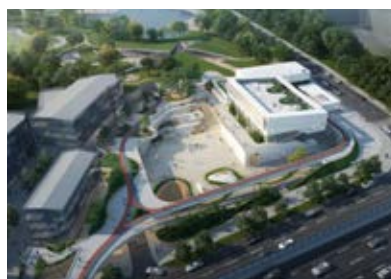
集变电站、汽车充电、邻里服务、运动健身、医疗卫生为一体，打造新型邻里空间
