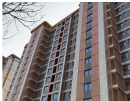
落水管隐藏于格栅之后
