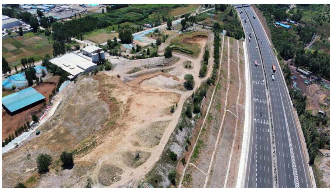
照片 3-1 废石场西部护坡及缓冲平台
