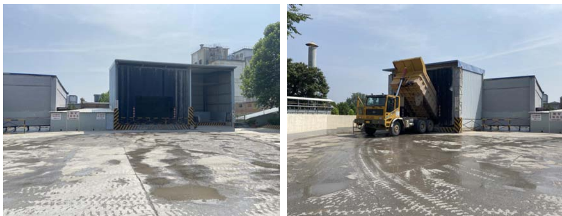
照片 3-6 破碎场破碎室及进料口
