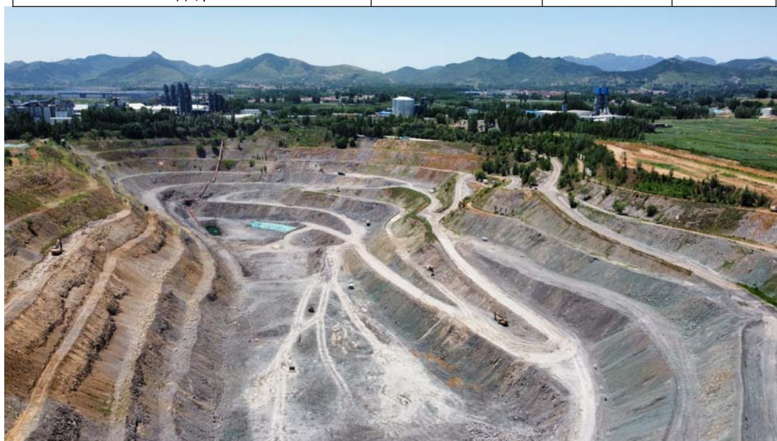
照片 3-3 露天采场现状（2023.06）
