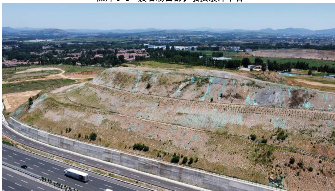
照片 3-2 废石场西北部护坡及缓冲平台
