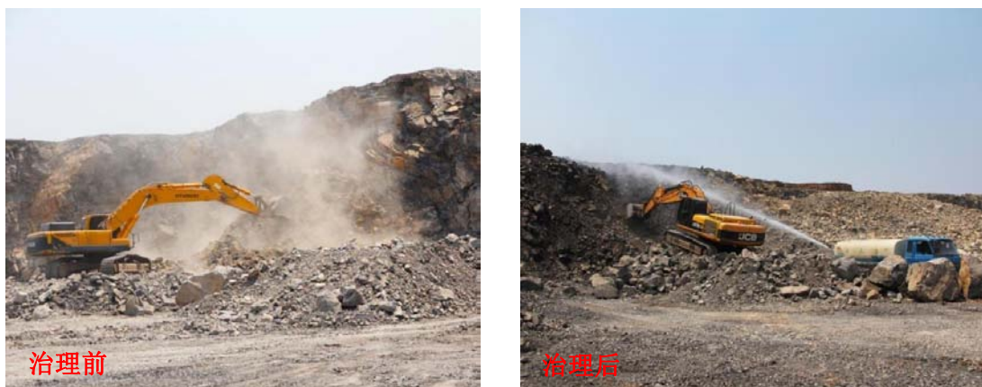
照片 2-11 采区挖掘作业前后对照图
