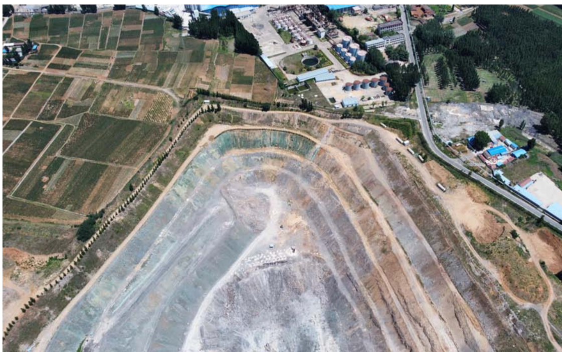
照片 2-2 矿区地貌现状（矿区北侧开采边坡及平台）
