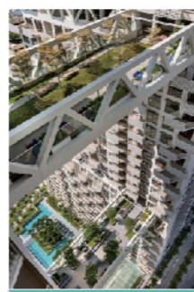
既有建筑增设连廊、无障碍设施
