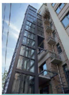
既有建筑增设电梯
