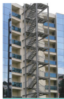
既有建筑增设的消防楼梯
