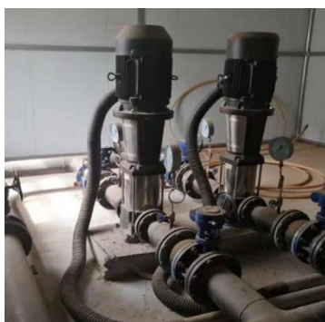
照片 1-1 矿区泵房
