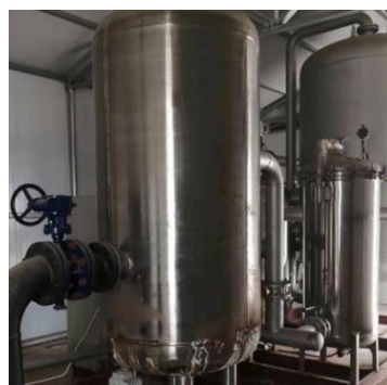
照片 1-2 矿区泵房
